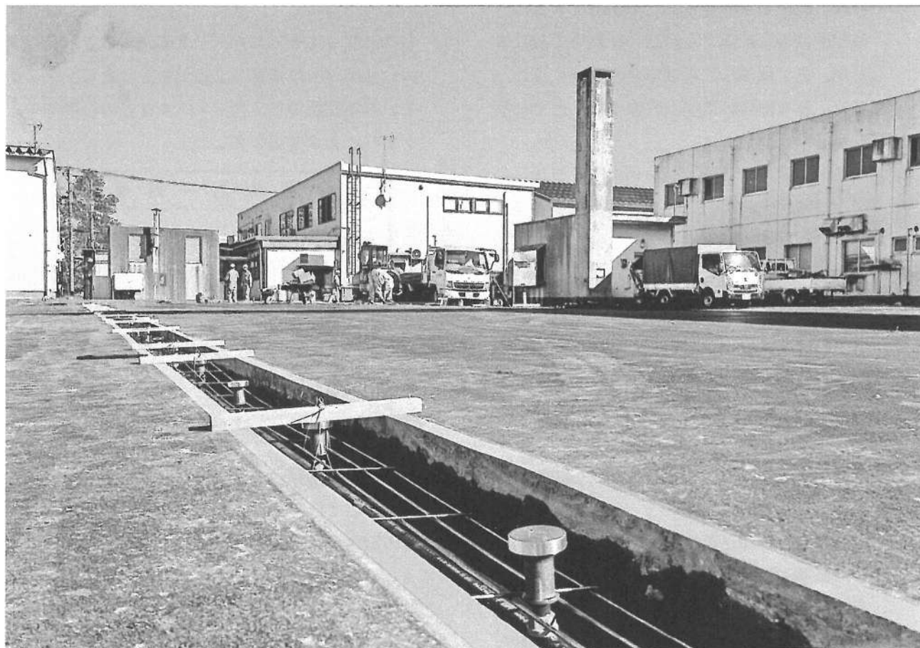
10/31～ 共同駐車場(No.2)消雪パイプ改修工事
