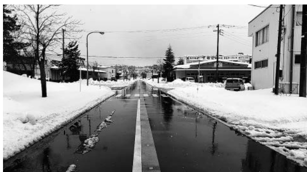
消雪パイプ敷設道路の雪消えの様子
