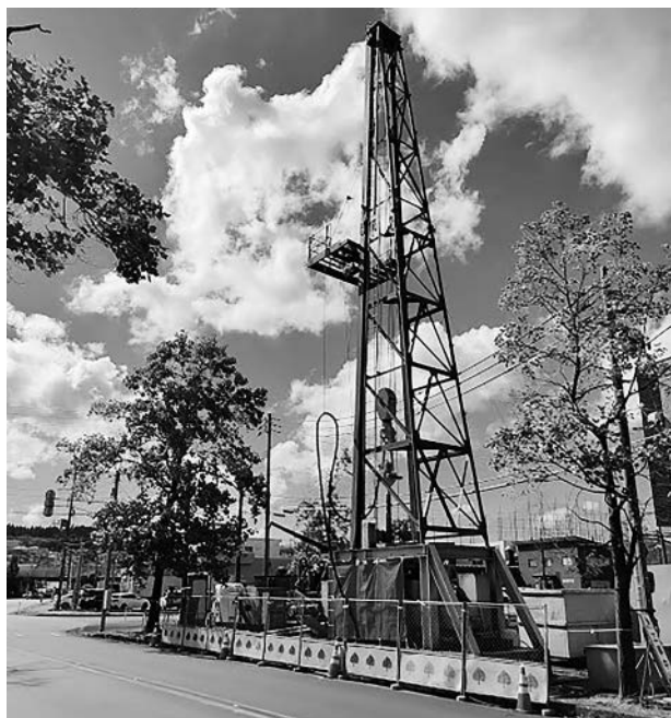
井戸掘削工事
