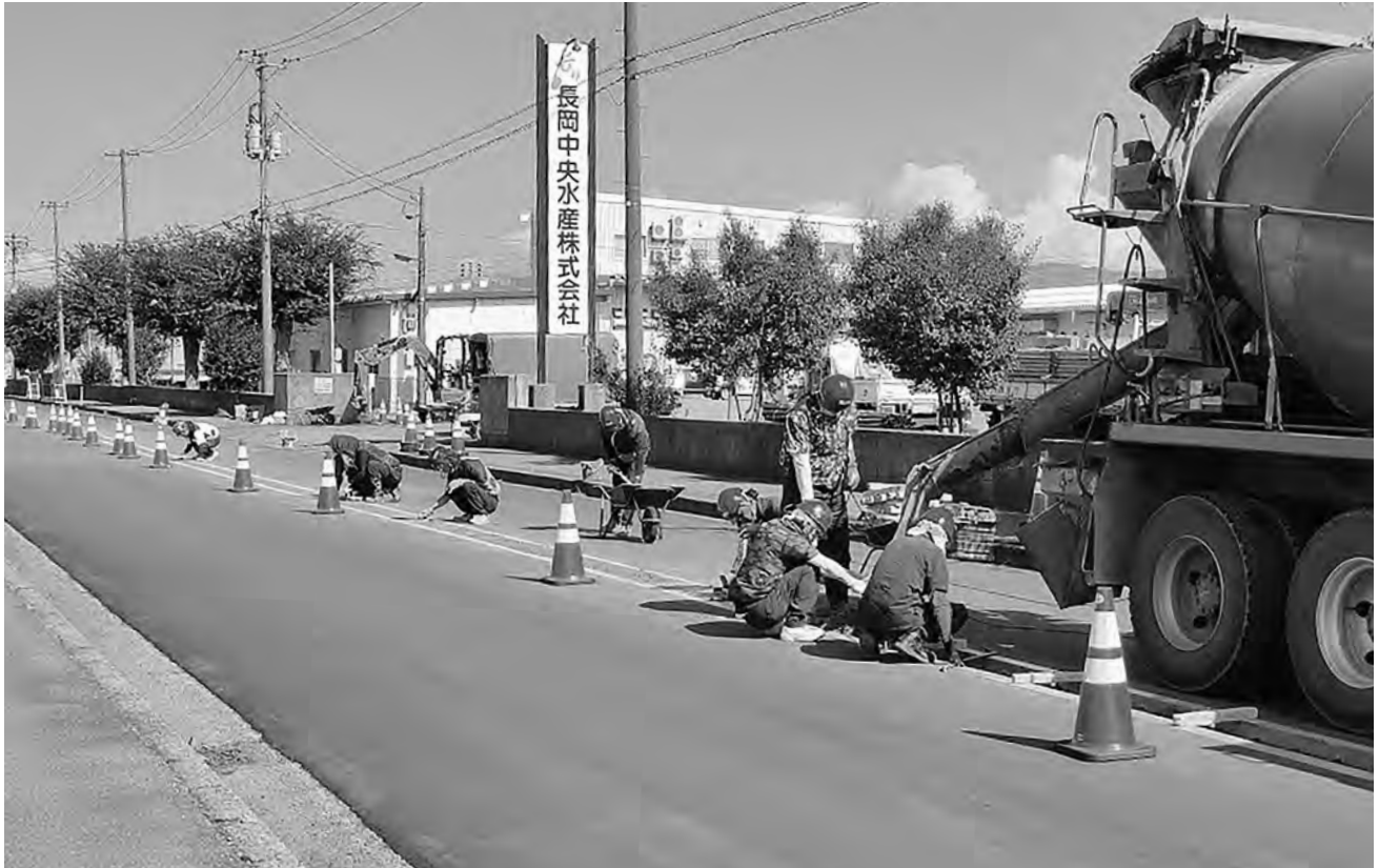
9 月 消雪パイプ敷設工事
